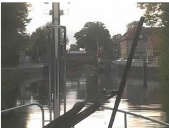
Klappbrücke und Schleuse in Zehdenick
